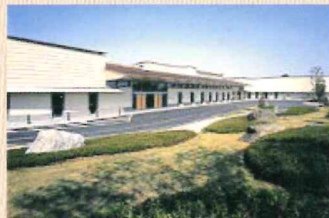
上尾伊奈斎場つつじ苑 〒362-0022上尾市瓦葺150
